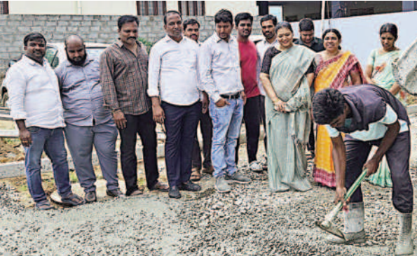
రోడ్డు నిర్మాణ పనులను పరిశీలిస్తున్న కార్పొరేటర్ సుజాతనాయక్ తదితరులు
